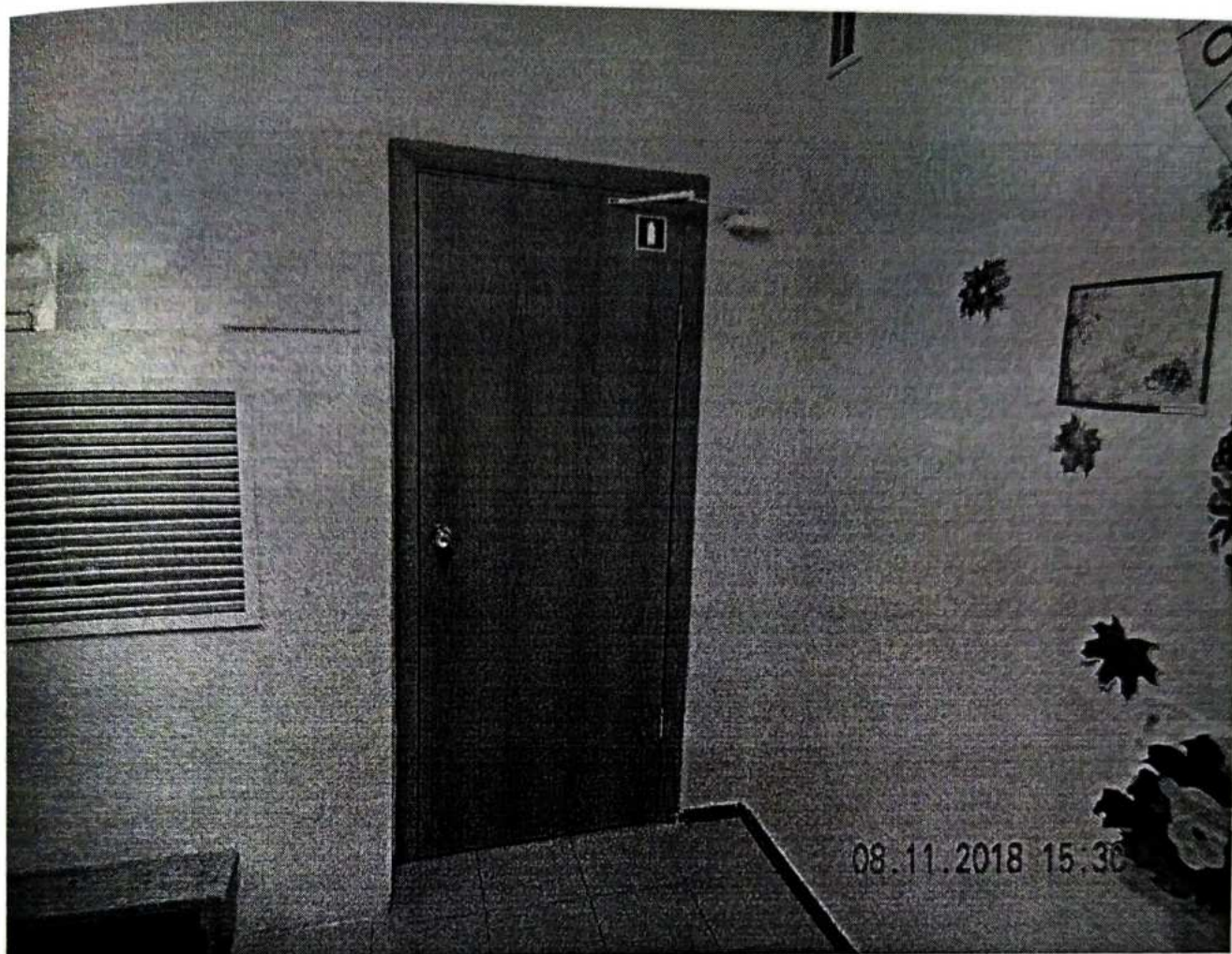
Фото № 12 Пути эвакуации
